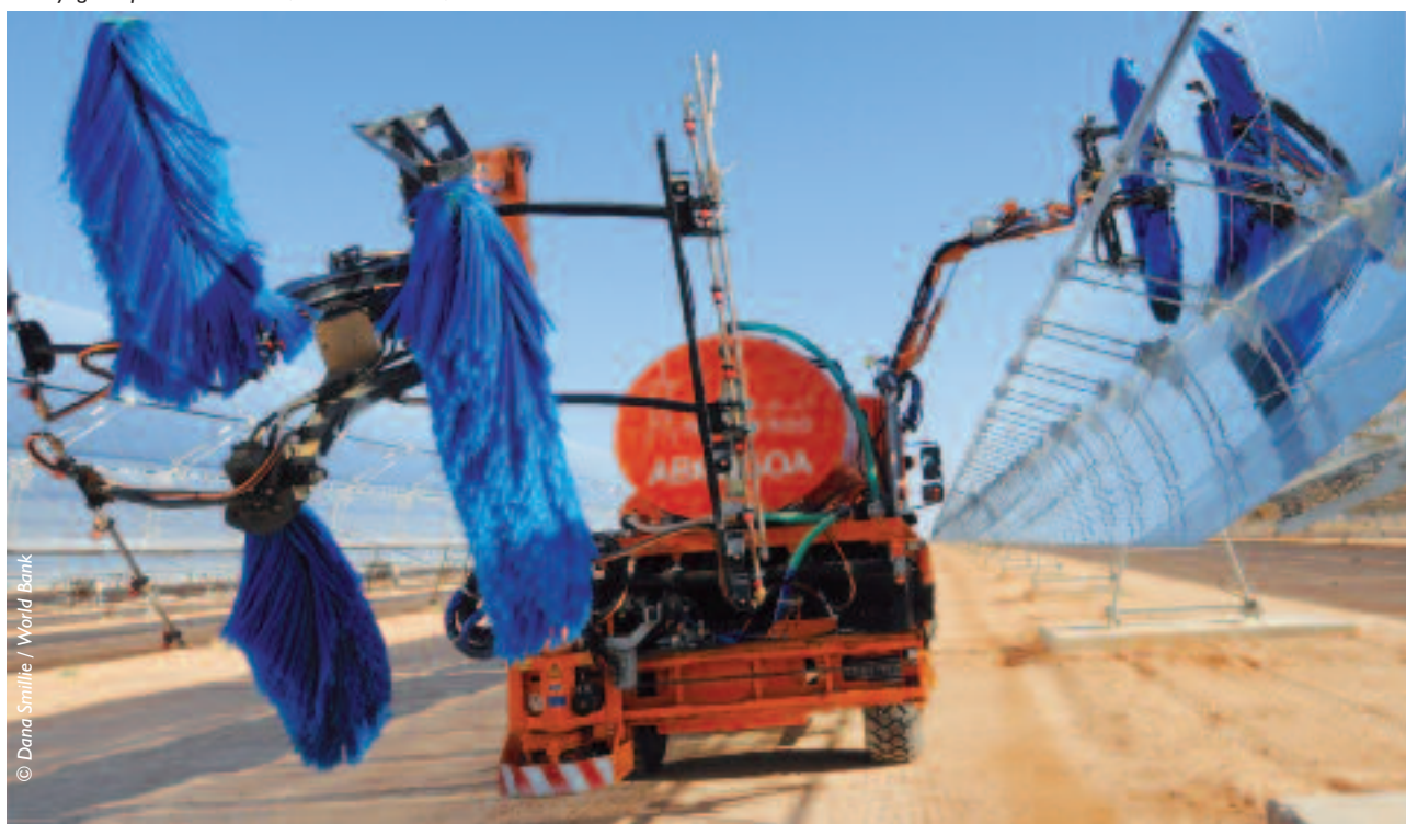
Nettoyage de panneaux solaires, Ain Beni Mathar, Maroc.
