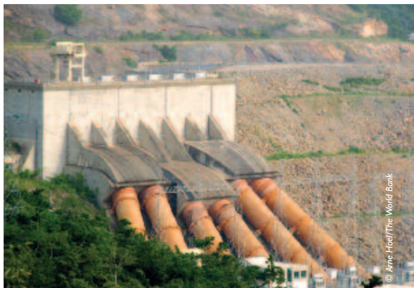
Centrale hydro-électrique, Ghana.
