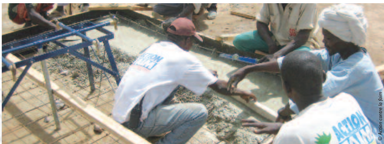
Construction d'un point d'eau, Tchad.
